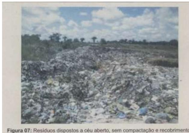
Figura 07: Resíduos dispostos a céu aberto, sem compactação e recobrimento.
